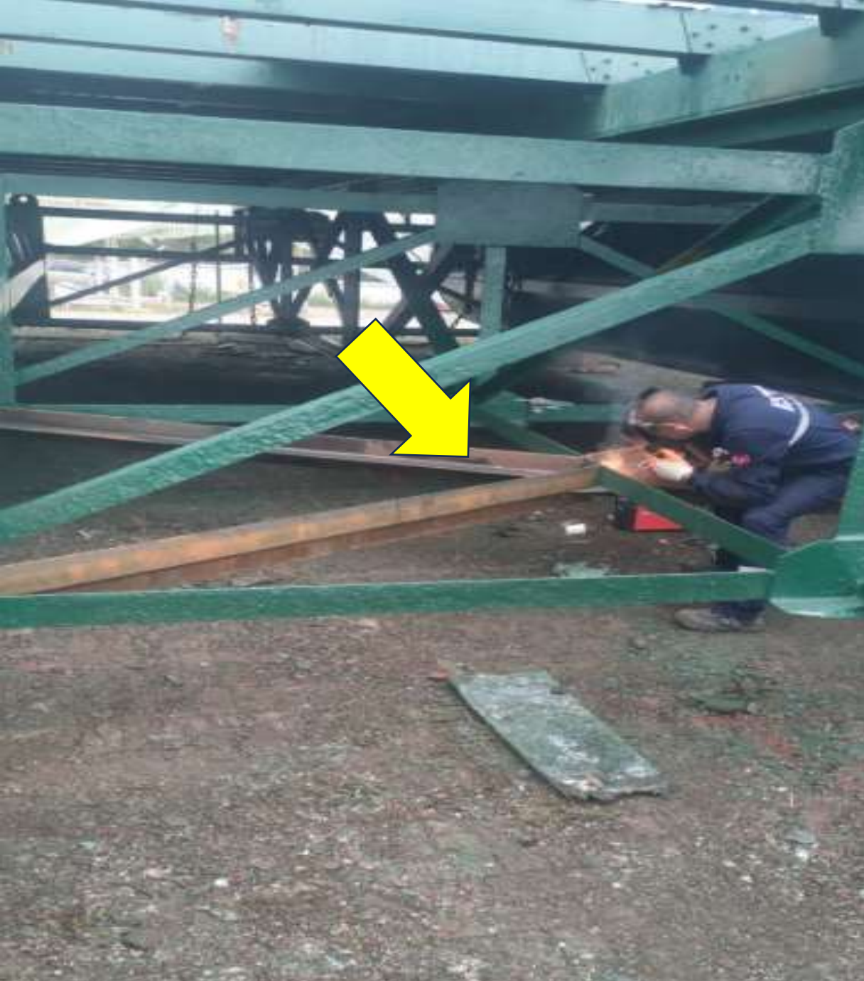
100 x 100 mm L KÖŞEBENT İLE DÜŞEY KONSTRÜKSİYON GÜÇLENDİRME ÇALIŞMASI
